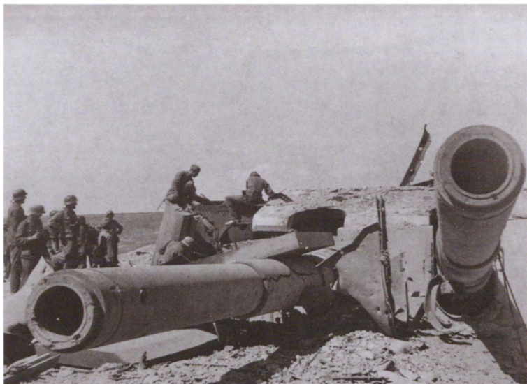
Немецкие солдаты осматривают разрушенную башню № 2 батареи № 30 в Севастополе. 1942 г.
