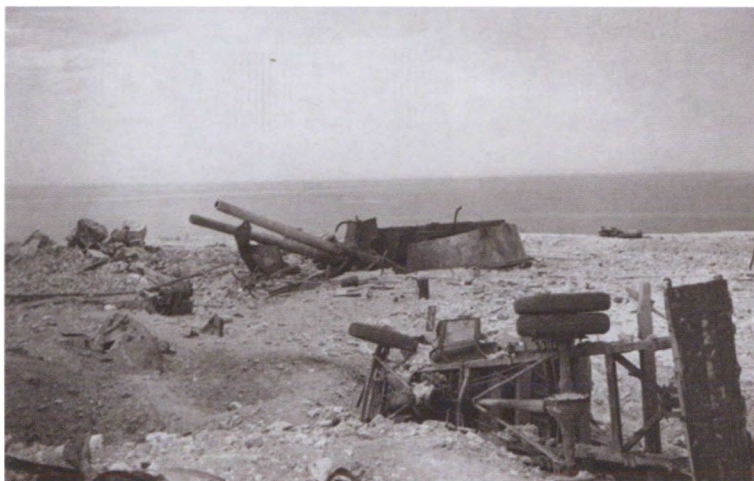
Внешний вид одной из башен 35-й ББ после подрыва 2 июля 1942 г.
